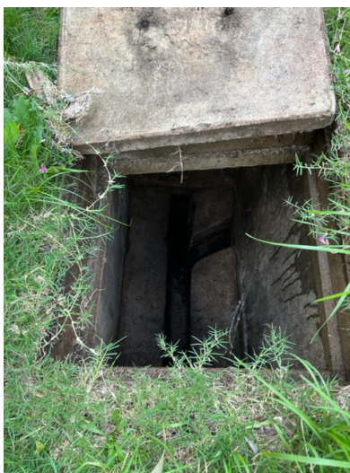
Foto de cámara de desagüe sanitario donde se conecta el baño.
