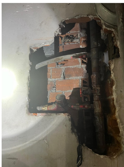
Fotos de doble pared en segundo subsuelo. Esta es la pared a intervenir para acceder a las instalaciones.
